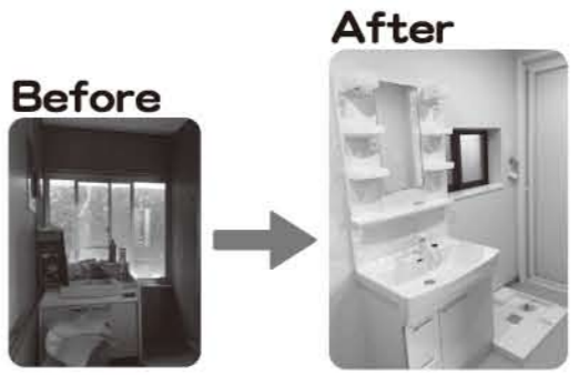
▲鏡の無かった洗面台を撤去し、位置を変え新たな洗面台を設置。使い勝手のいい洗面台になりました。
